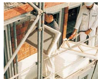
Нанесение клеящего раствора
